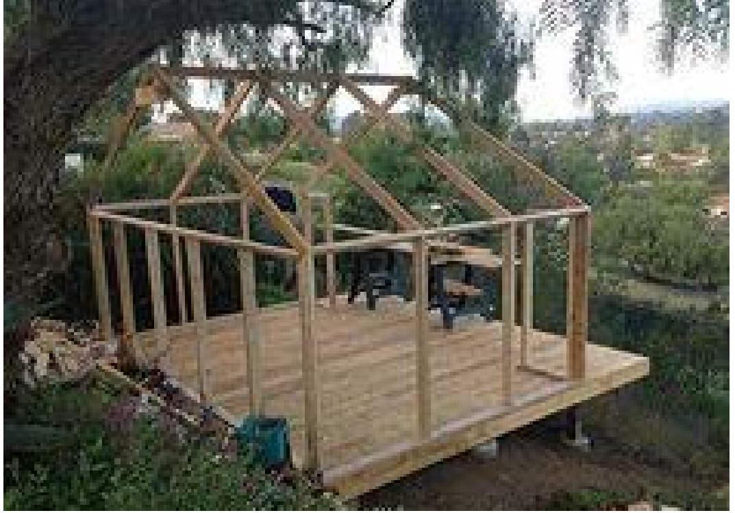
Şekil 3.4: Ahşap makaslı çadır.
