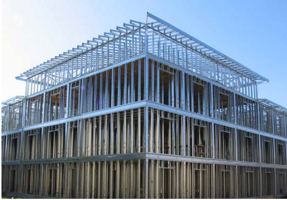
Şekil 4.1: Üç katlı hafif çelik bir sosyal yapı taşıyıcı sistemi.
