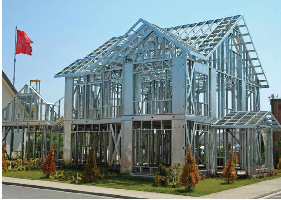
Şekil 4.4: Hafif çelik prefabrik yapıların taşıyıcı sistem görünüşü.
