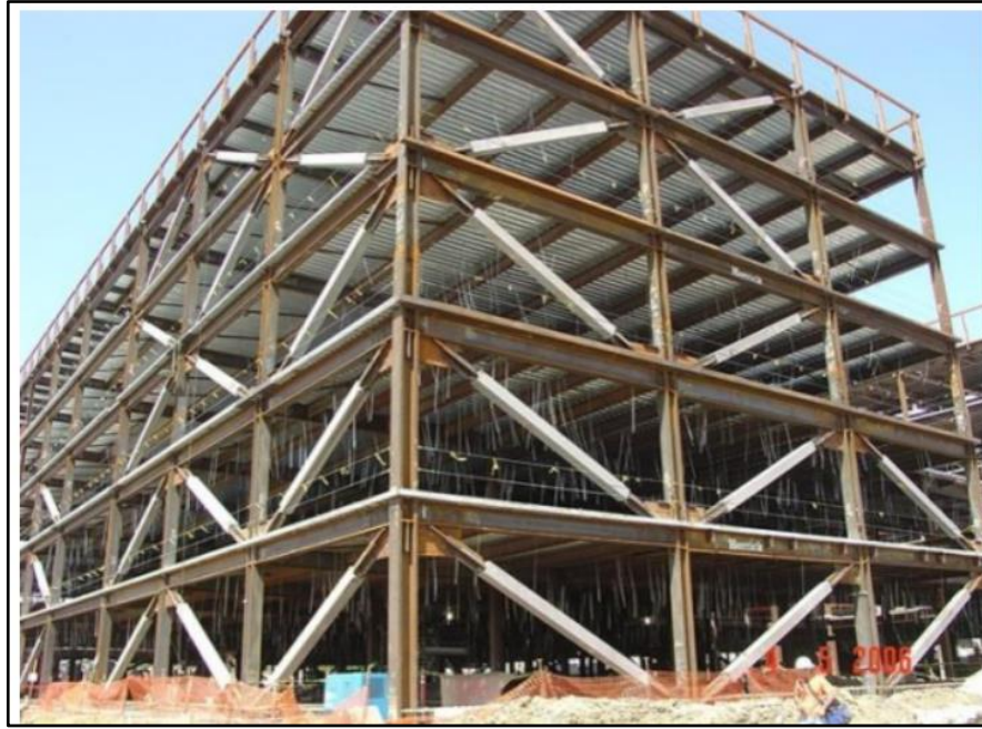
Şekil 2.8: Burkulması önlenmiş çaprazlı çelik çerçeve örneği.
