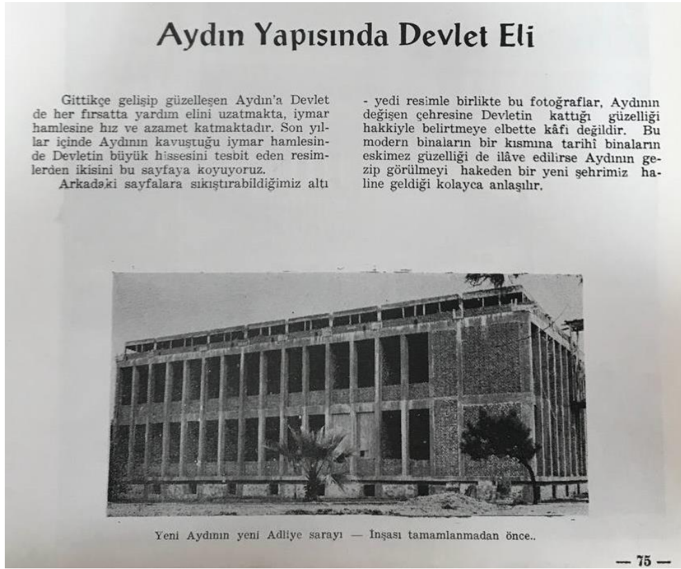
Şekil 4.18: Aydın Yapısında Devlet Eli Başlıklı Yazıda Adliye Binasının İnşaat Süreci Fotoğrafı. (Anonim,1954).
