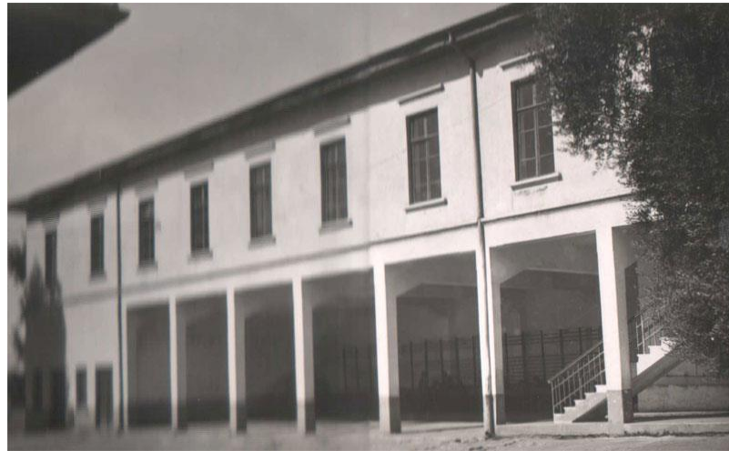
Şekil 4.35 : Aydın Lisesi Ek Bina (Aydın,2013).
