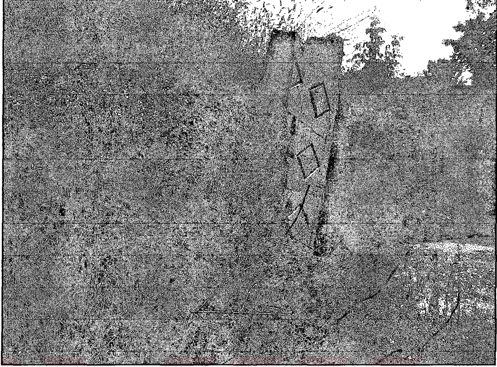
Resim 5.9: Heyelân sonucu yıkılmış istinat duvarı.
