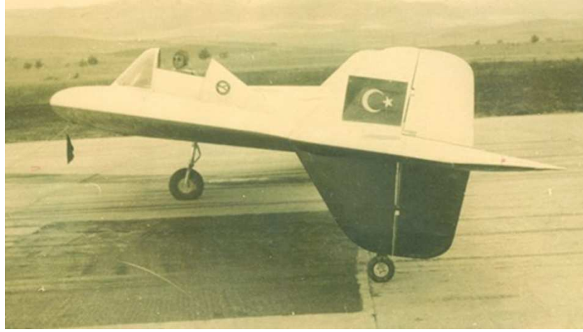
Şekil 4.31.: THK-13 Uçan Kanat Planörü
