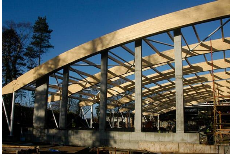
Şekil 3.1: Glulam kirişlerden elde edilmiş çatı örtüsü [Web 7, 2025].
