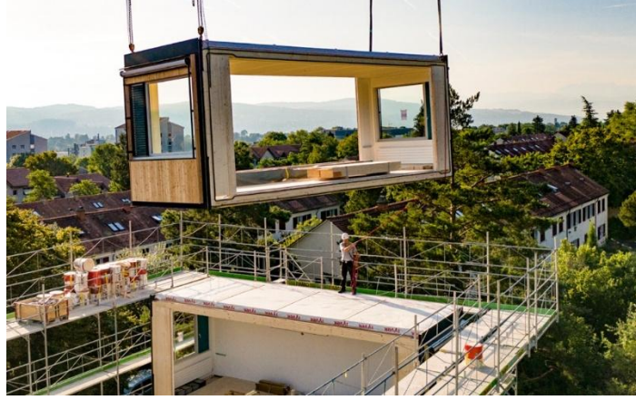
Şekil 3.4: Modül sistemin vinç yardımı ile kurulumunun yapılması [Web 10, 2025].
