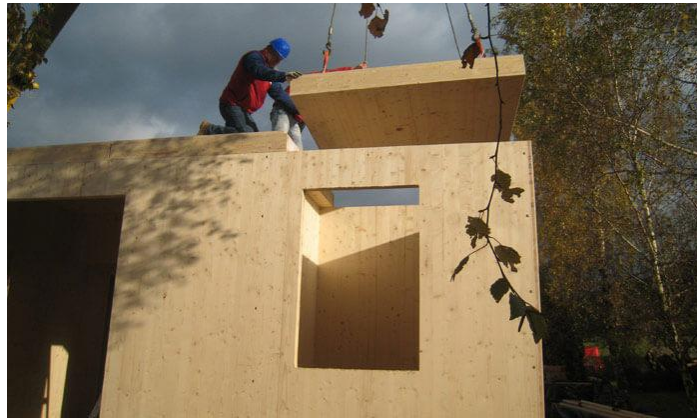
Şekil 3.2: CLT panellerin yerleşimi [ Web 8, 2025 ].
