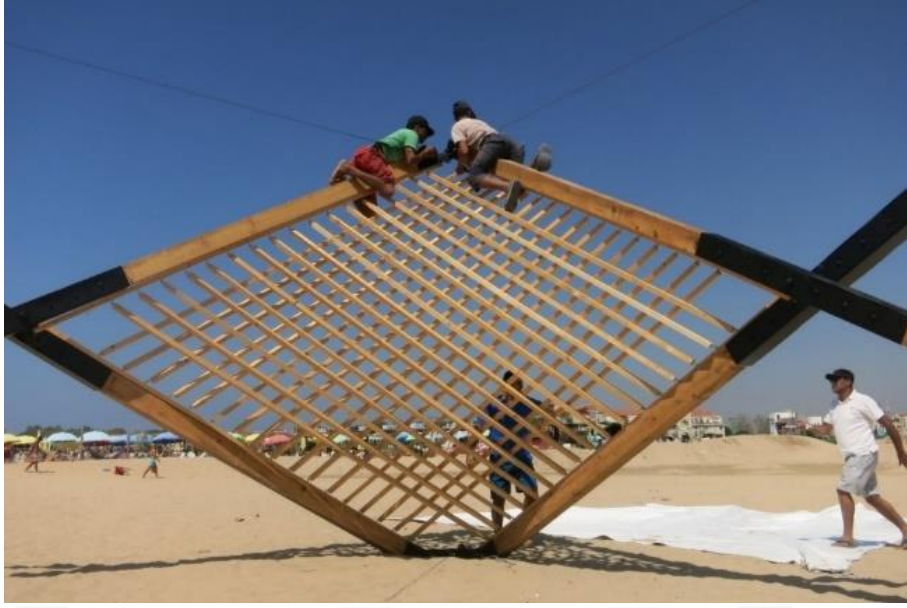
Şekil 3.14: Marah Pavyonunun yapım aşaması.
