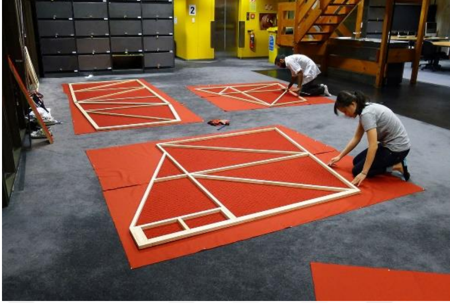
Şekil 3.22: Merdiveni örtecek strüktürel sistemin ve kaplama malzemesinin birleşme ve yapım aşaması.
