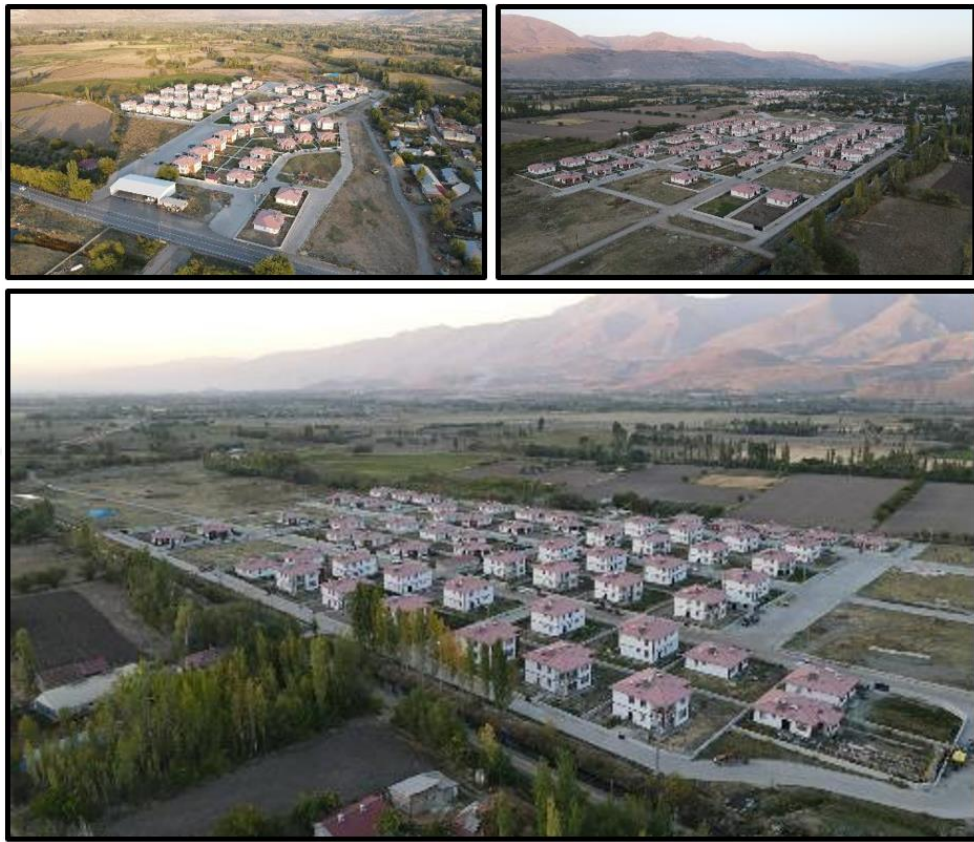
Şekil 4.47: Uluköy iskân konutları yeni yerleşim yeri [Erzincan Çevre, Şehircilik ve İklim Değişikliği İl Müdürlüğü Arşivi, 2022].
