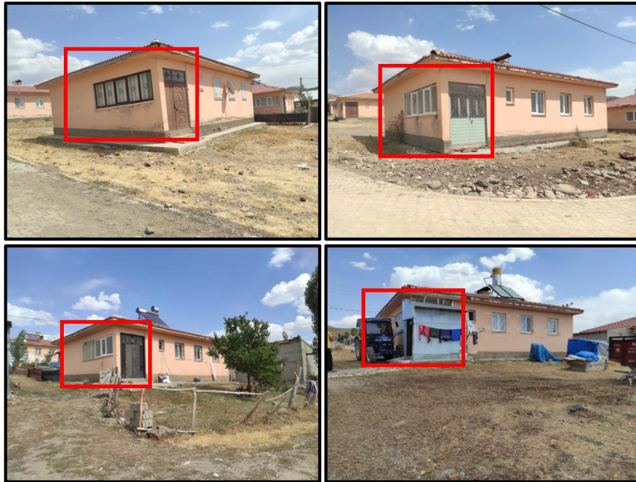
Şekil 4.59: Kalecik köyü afet konutlarında terası kapatılan konut örnekleri (Tülay İnanç arşivi, 2022).
