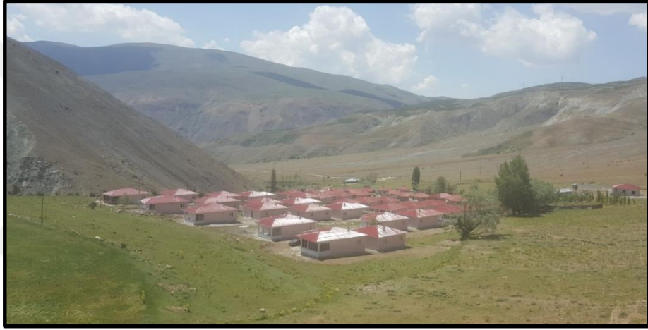
Şekil 3.46: Muhtemel su baskını afeti nedeni ile Erzincan Koçyatağı köyünde yapılan yeni yerleşim yeri ve konutlar [Erzincan İl Afet ve Acil Durum Müdürlüğü Arşivi, 2023].
