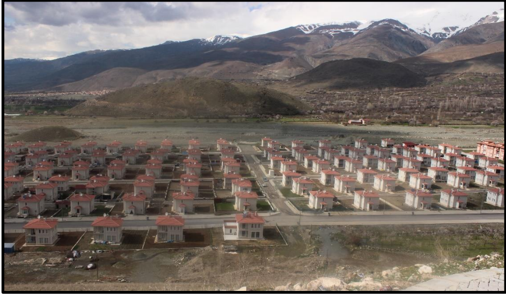
Şekil 3.33: Erzincan Üzümlü 'de Ahıska Türkleri için inşa edilen iskân konutları [Erzincan Çevre, Şehircilik ve İklim Değişikliği İl Müdürlüğü Arşivi, 2023].
