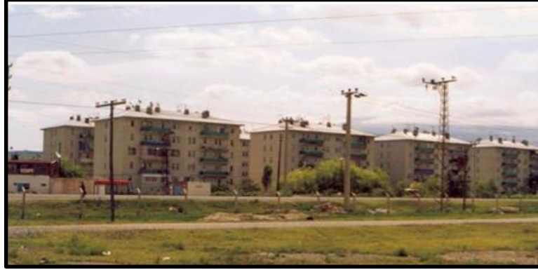
Şekil 3.32: Iğdır'da Ahıska Türkleri için inşa edilen iskân konutları [Kayseri Çevre, Şehircilik ve İklim Değişikliği İl Müdürlüğü Arşivi, 2023].
