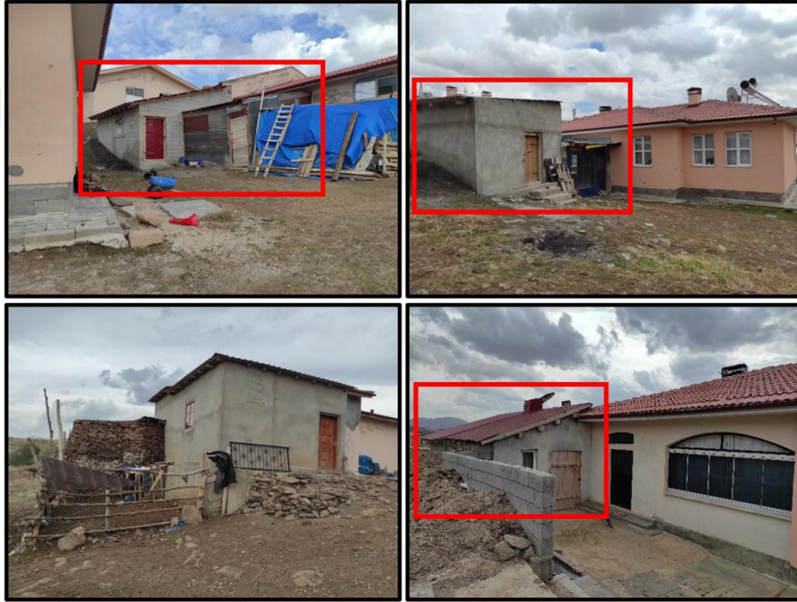
Şekil 4.72: Kalecik köyü iskân konutlarında bahçesine odunluk/kömürlük, garaj, tandır evi gibi eklenti yapılan konut örnekleri (Tülay İnanç arşivi, 2022).
