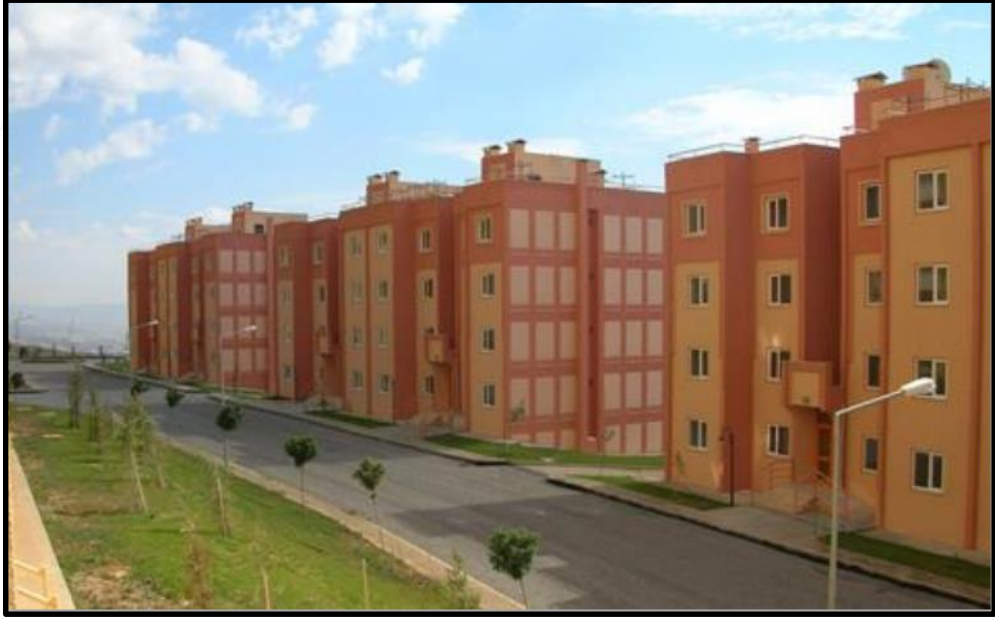
Şekil 3.31: Kahramanmaraş Serintepe’de inşa edilen göçebe iskân konutları [Kayseri Çevre, Şehircilik ve İklim Değişikliği İl Müdürlüğü Arşivi, 2023].
