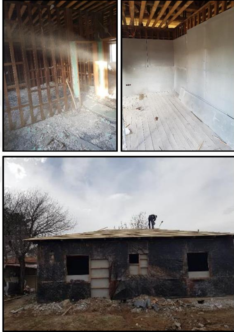
Şekil 4.11: Gülabibey Mahallesi'nde tadilat yapılan ahşap kurma ev (Tülay İnanc arşivi, 2019).
