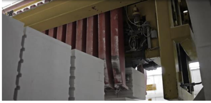
Şekil 4.12: Otaklavlardan çıkan gazbetonu ayırma işlemi.
