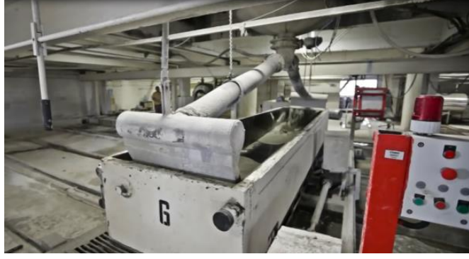
Şekil 4.11: Gazbeton hammaddesinin kalıplara aktarıldığı alan.
