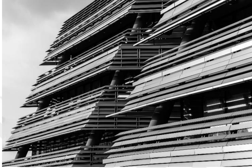
Şekil 4.25: Zorlu Levent 199 alüminyum güneşlikler.
