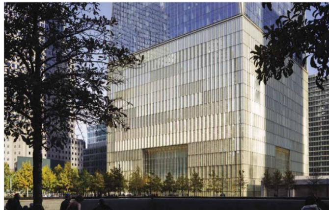
Şekil 4.79: One World Trade Center Binası giriş lobisi.
