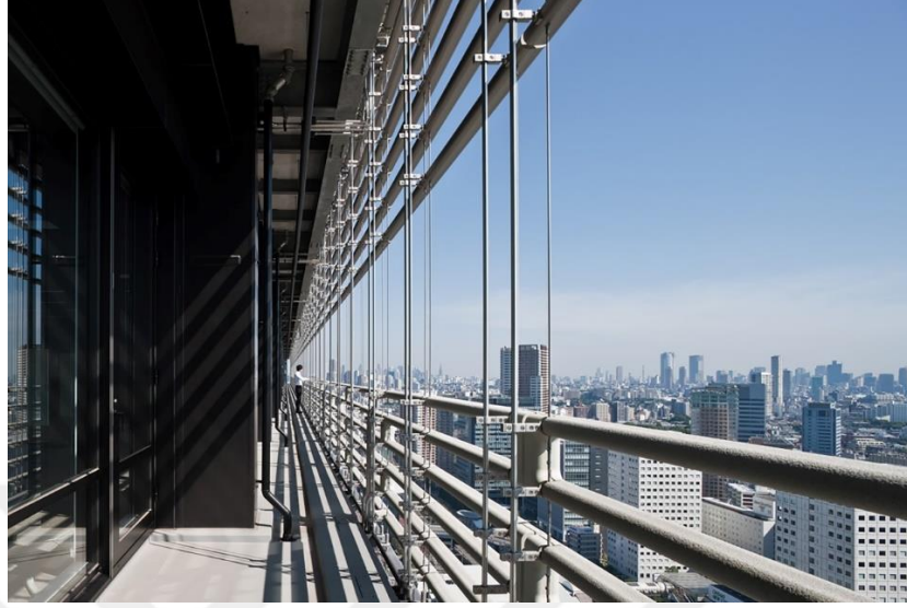
Şekil 4.58: BioSkin için balkon korkuluklarında kullanılan seramik borular.
