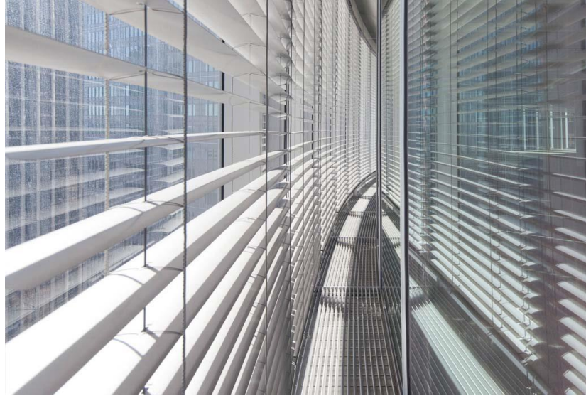
Şekil 4.51: 1 Bligh Sokağı Binası otomatik panjurlar.
