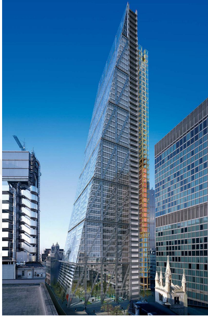
Şekil 4.62: The Leadenhall Binası.
