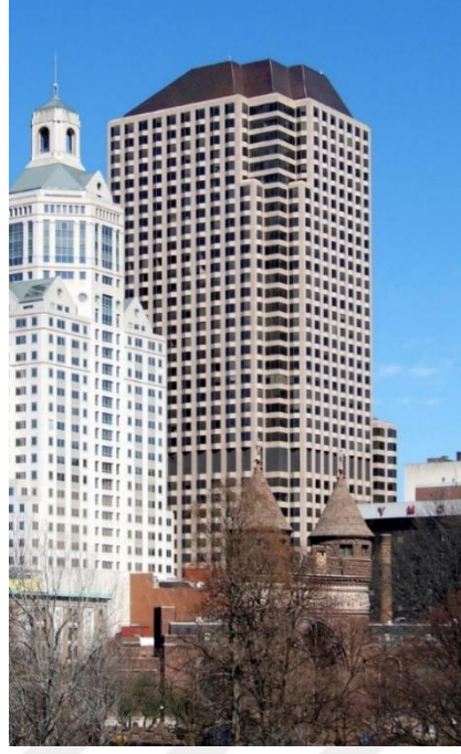
Şekil 2.11: İlk Akıllı Bina ‘City Place’.
