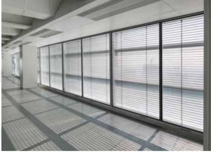
Şekil 4.56: Pearl River Kulesi otomatik panjur sistemi.
