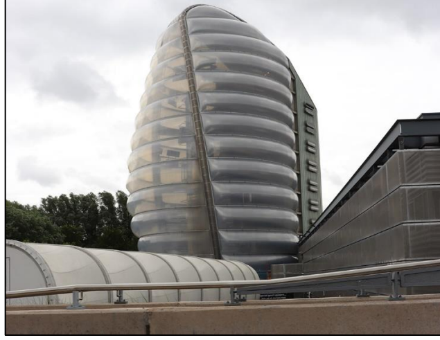
Şekil 2.12.: Britanya Ulusal Uzay Merkezi Roket Kulesinde ETFE kullanımı.
