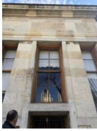
Şekil 5.146: Maiyet Köşkü kuzey cephesi pencere görünümü.
