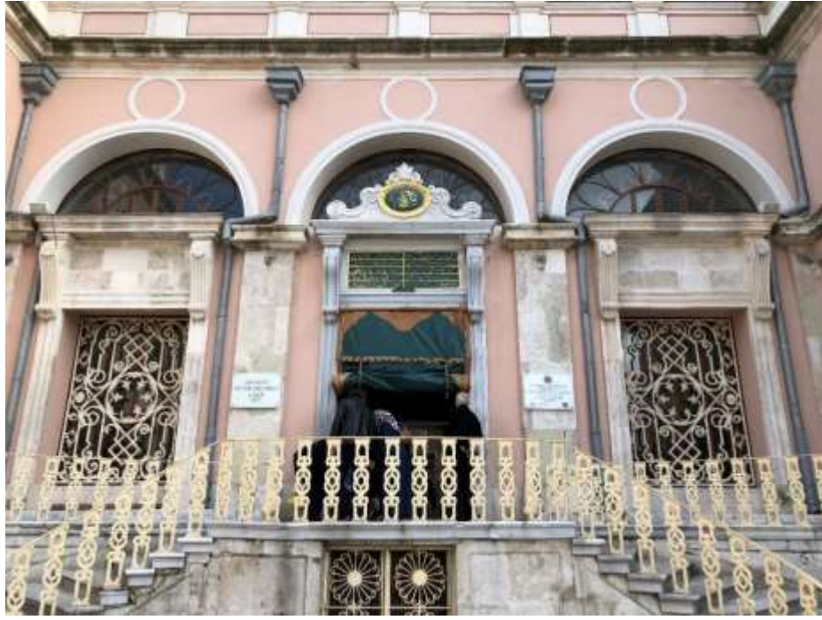
Şekil 5.2: Ortaköy Camii, Giriş Kapısı.
