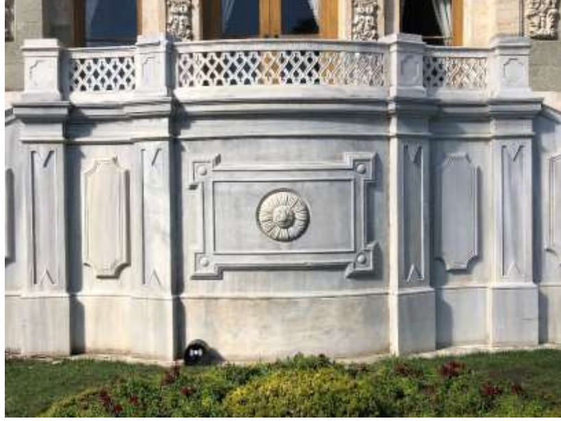
Şekil 5.137: Maiyet Köşkü güney cephe merdiven.
