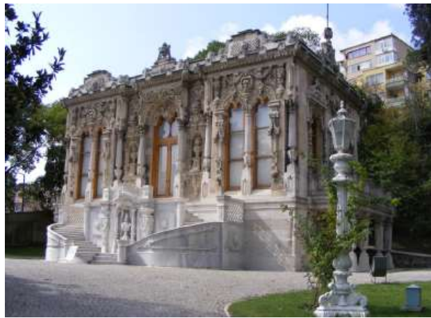
Şekil 5.104: Merasim Köşkü doğu cephesi.
