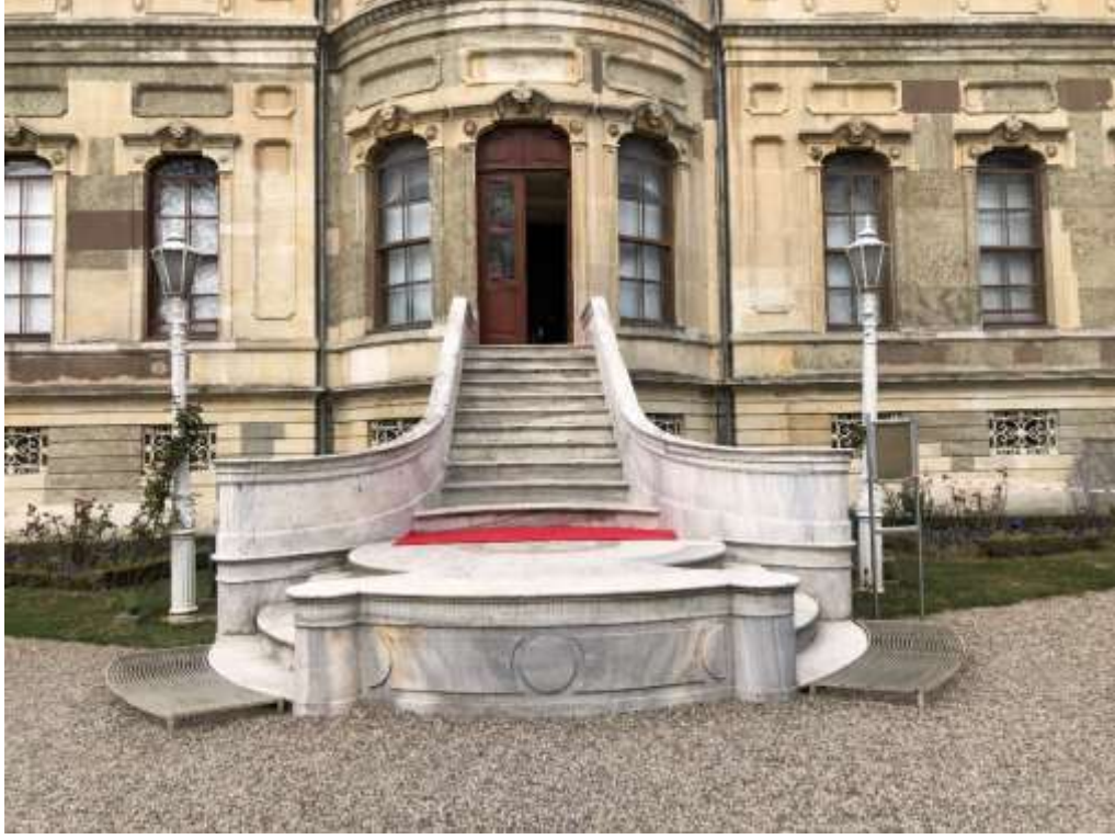
Şekil 5.65: Küçüksu Kasrı, Giriş Merdiveni.
