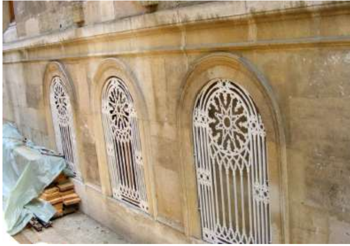
Şekil 5.109. Merasim Köşkü, batı cephesi bodrum katı.
