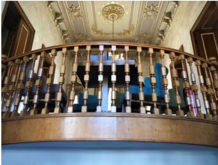
Şekil 5.117: Maiyet Köşkü merdiven korkuluk görünümü.
