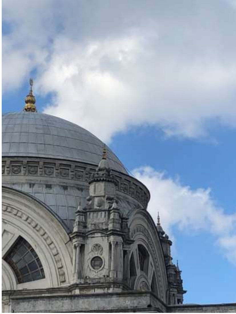
Şekil 5.42: Dolmabahçe Camii, ağırlık kulesi.
