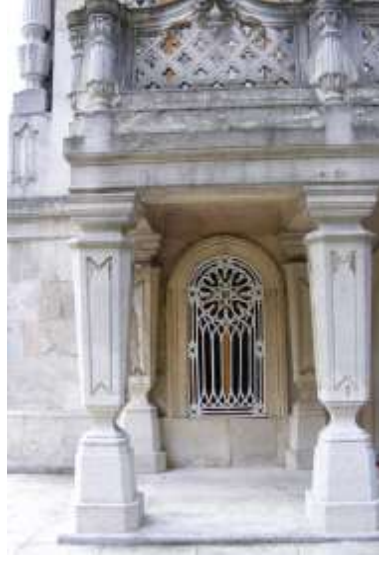
Şekil 5.112: Merasim Köşkü güney cephesi bodrum katı.
