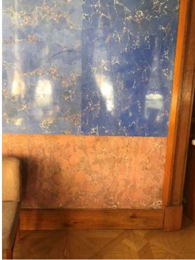
Őekil 5.130. Maiyet K şk  3 No'lu oda duvar detayı.
