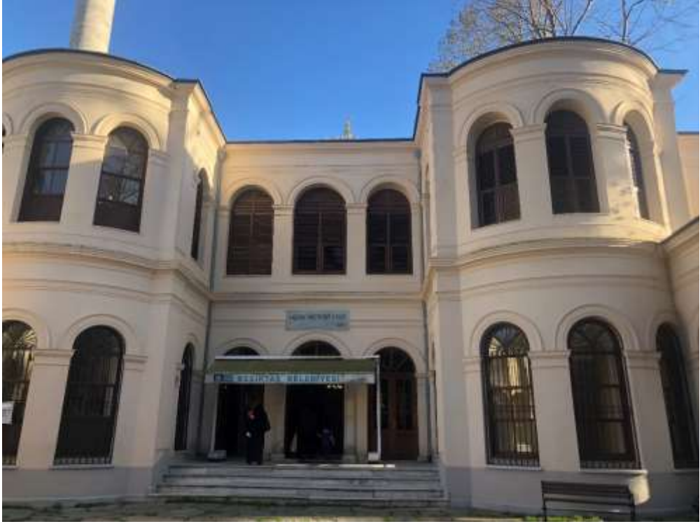
Şekil 3.14: Küçük Mecidiye (Çırağan) Camii, giriş cephesi.
