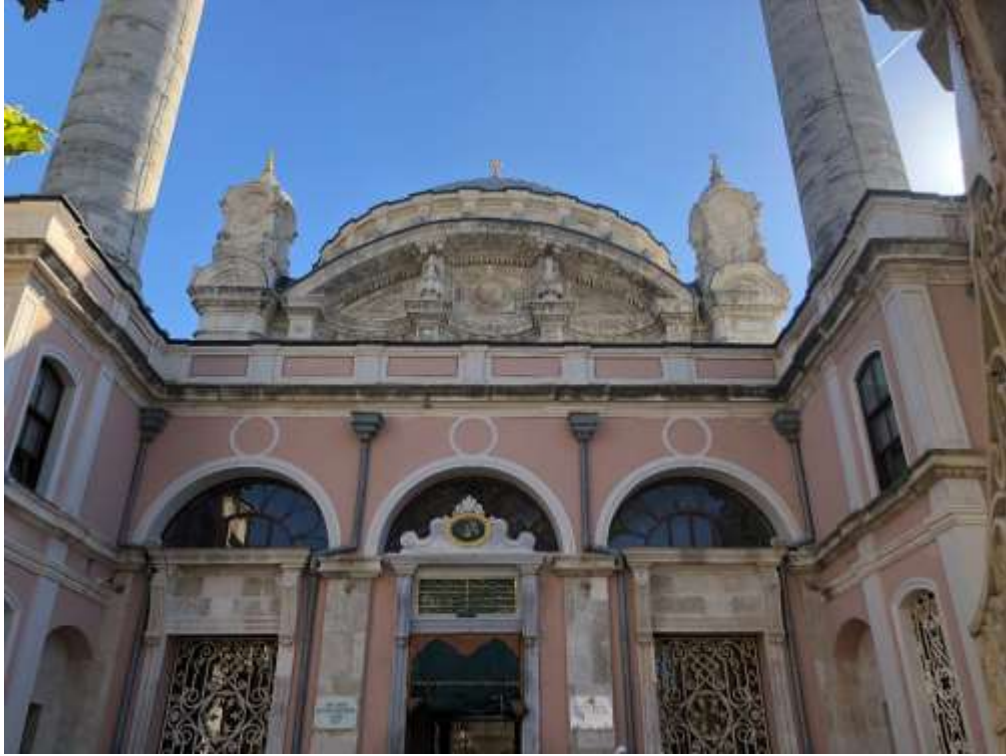
Şekil 5.17: Ortaköy Camii, hünkâr kasrı ön cepheden görünüm.
