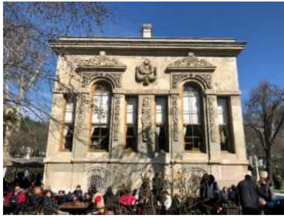
Şekil 5.148: Maiyet Köşkü batı cephesi.
