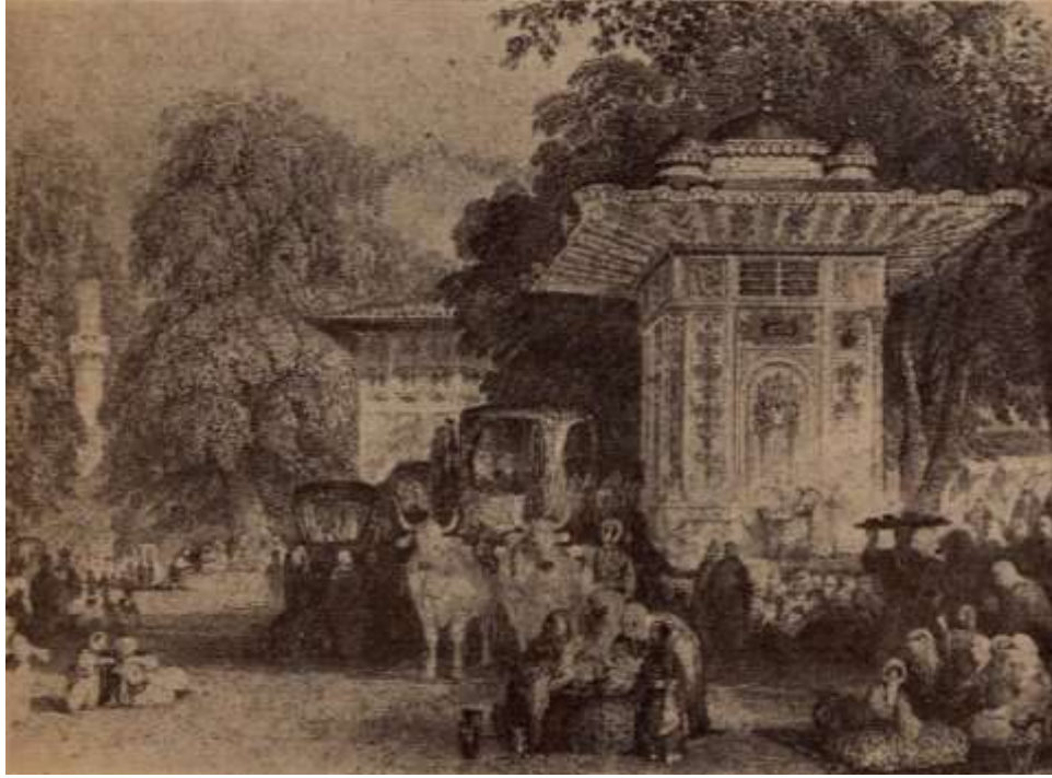
Şekil 5.50. Küçüksu Çeşmesi-Thomas Allom.
