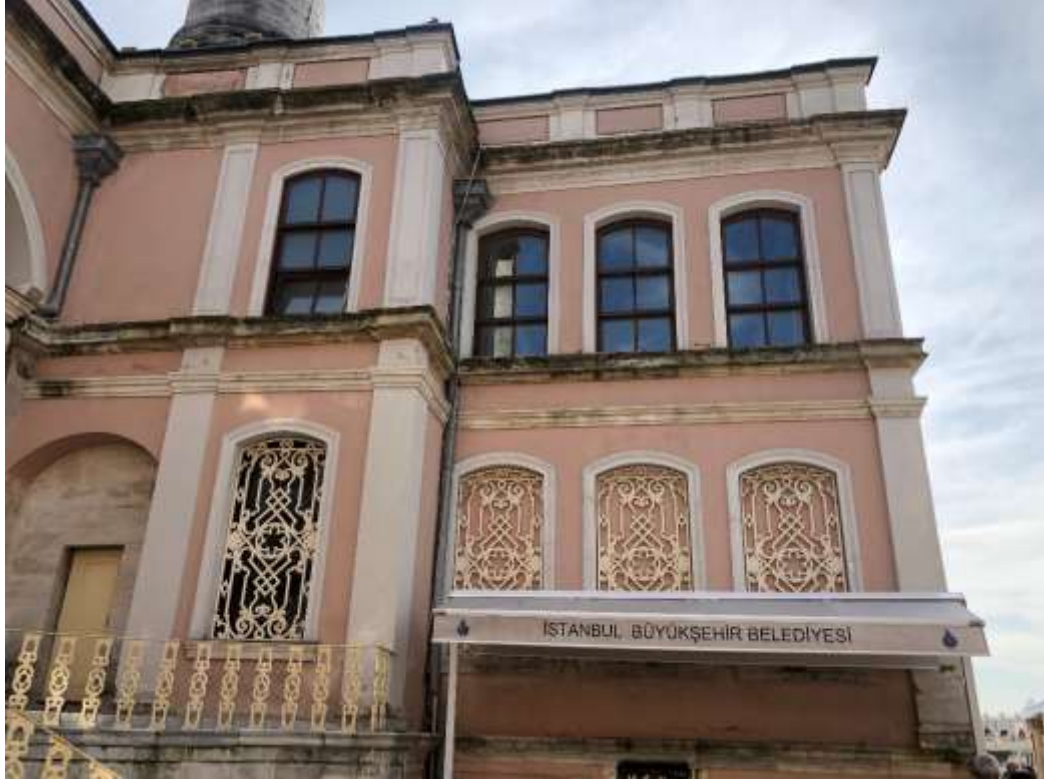
Şekil 5.18: Ortaköy Camii, Hünkâr Kasrı.
