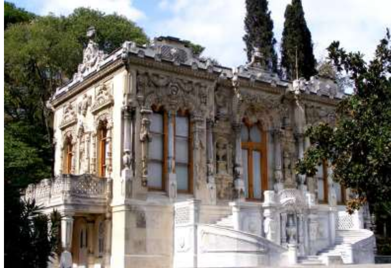
Şekil 5.111: Merasim Köşkü, güney cephesi.
