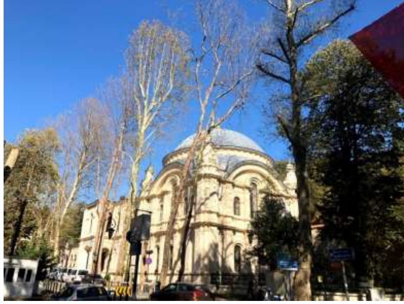
Şekil 3.4: Küçük Mecidiye (Çırağan) Camii, genel görünüş.
