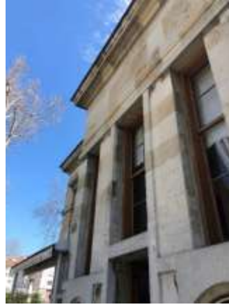
Şekil 5.147: Maiyet Köşkü kuzey cephesi köşe görünümü.
