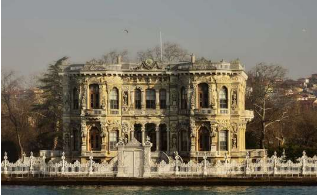
Şekil 5.70: Küçüksu Kasrı, deniz cephesi.
