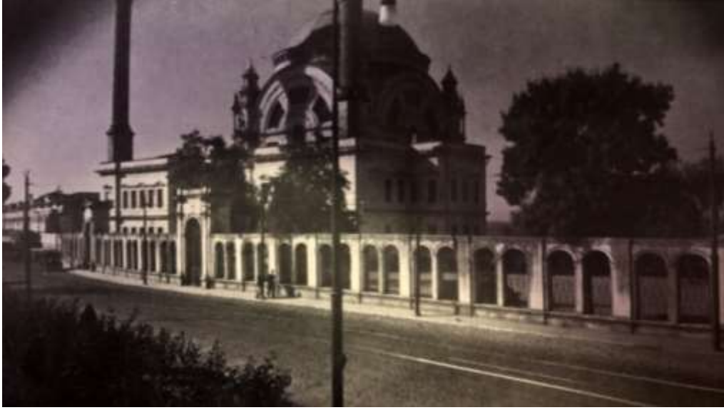
Şekil 5.25: Dolmabahçe Camii Çevresinde Bulunan, Sonradan Yıkılan Avlu Duvarı.
