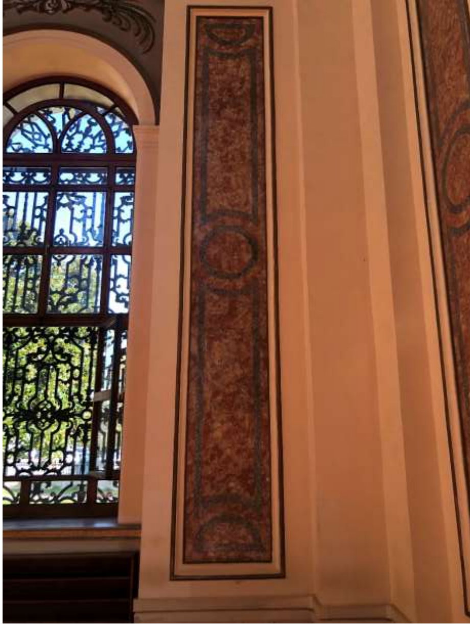
Şekil 5.34: Dolmabahçe Camii stucco (stuc) sıva örneği.
