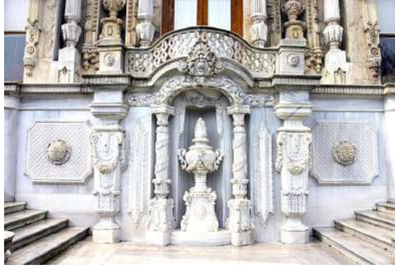
Şekil 5.106: Merasim Köşkü doğu cephesi merdiveni.
