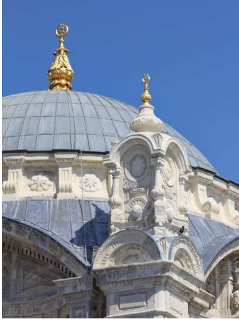
Şekil 5.20. Ortaköy Camii, ağırlık kulesi.
