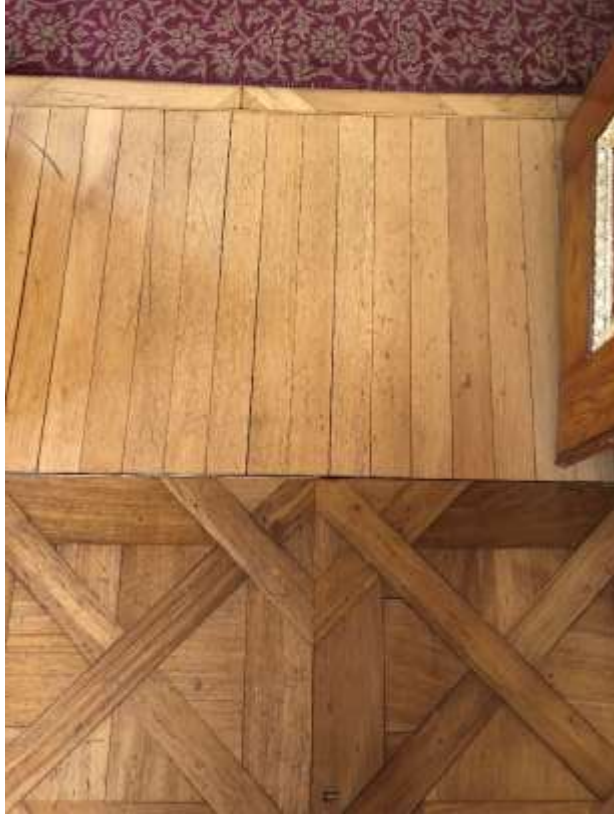
Şekil 5.122: Maiyet Köşkü 1 no'lu oda yer kaplama detayı.
