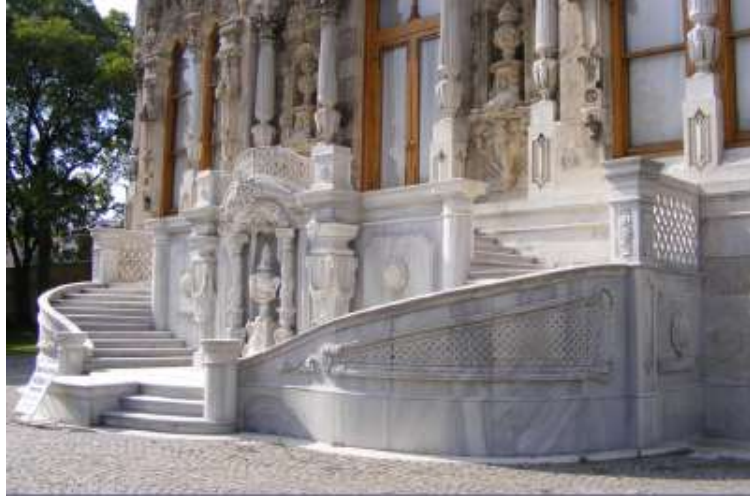
Şekil 5.105: Merasim Köşkü doğu cephesi merdiveni.
