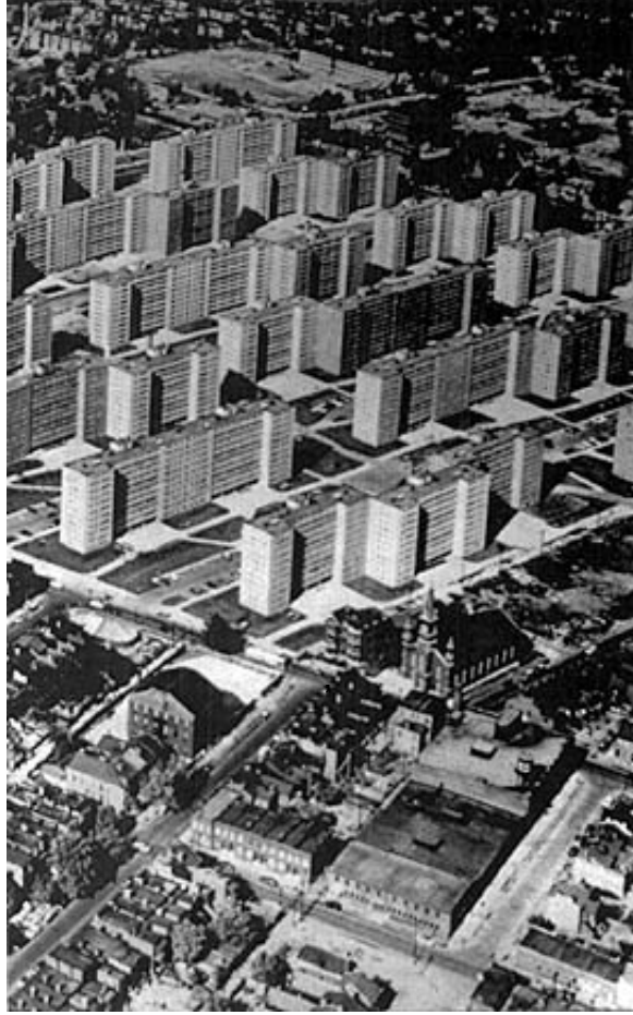
Resim 3.1. Pruitt-Igoe Toplu Konutları'nın Yıkılmadan Önceki Hali St.Louis Şehri, Missouri Eyaleti, ABD 1955 ( http://www.nyc-architecture.com/ARCH/Pruitt_Igoe_1955.jpg )
