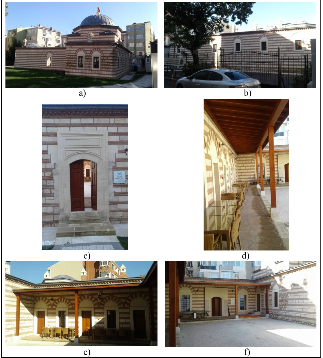
Şekil 4.19: a) N.M.M. ön cephe (2017), b) Arka cephe (2017), c) Giriş kapısı (2017); d,e) Revaklar (2017), f) Avlu (2017), g) Baş oda (2017), h) Hücre (2017); ı,i) Yapıya uyumsuz tesisat donatıları (2017).
