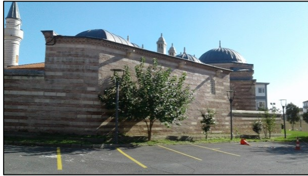
Şekil 3.56: H.İ.M. yol cephesi (2017).
