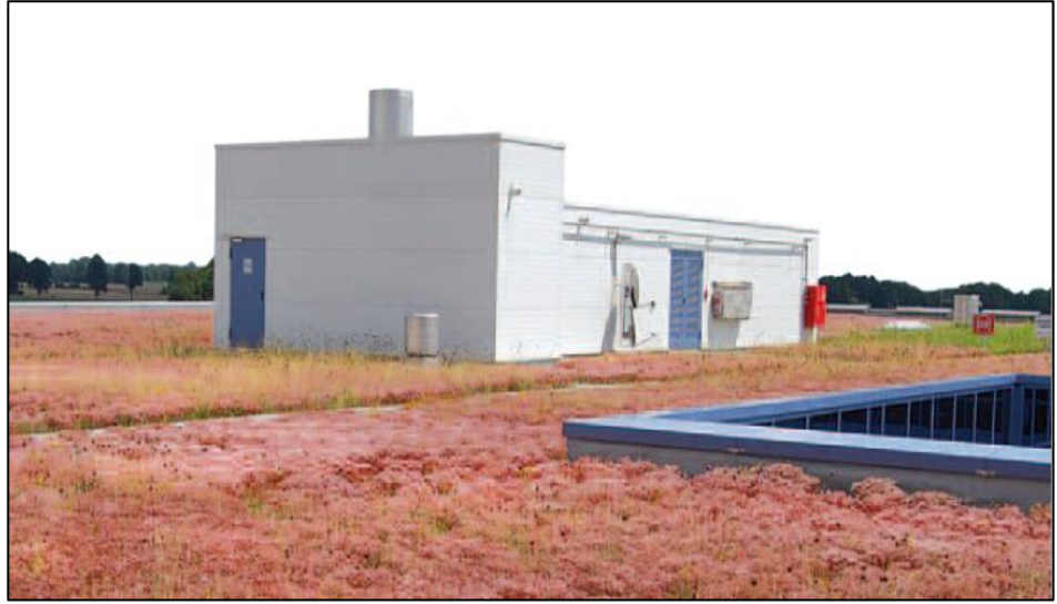
Şekil 3.2: Ekstensif yeşil çatı örneği.
