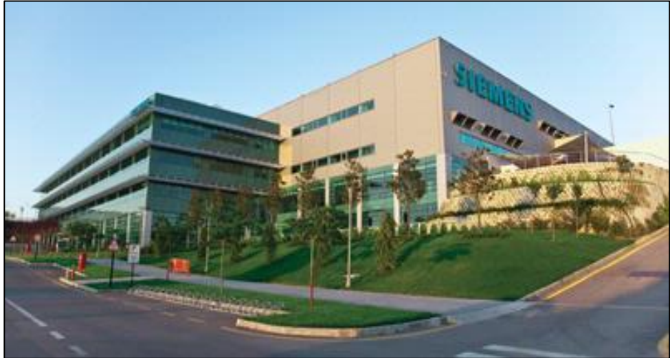
Şekil 4.3: Siemens Gebze Fabrikası.
