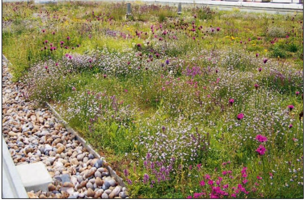
Şekil 3.1: Ekstensif yeşil çatı örneği.
