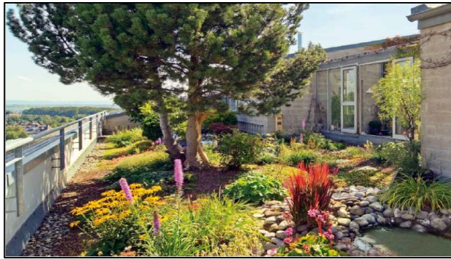
Şekil 3.4: İntensif yeşil çatı örneği.
