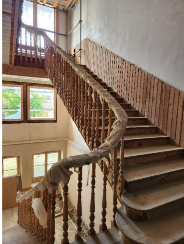
Şekil 5.10: Ahmet Ratıp Paşa Köşkü ahşap merdiven.
