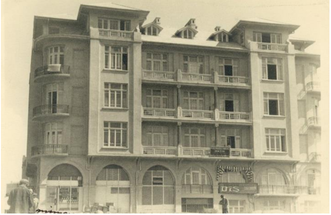
Şekil 4.13: Çocuk Sarayı (Himaye-i Etfal) Apartmanı 1929 (SALT Araştırma, FOTO_AHANKA218, 1929).
