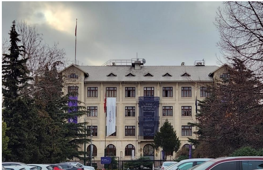
Şekil 5.102: Devlet Demiryolları Apartmanı.
