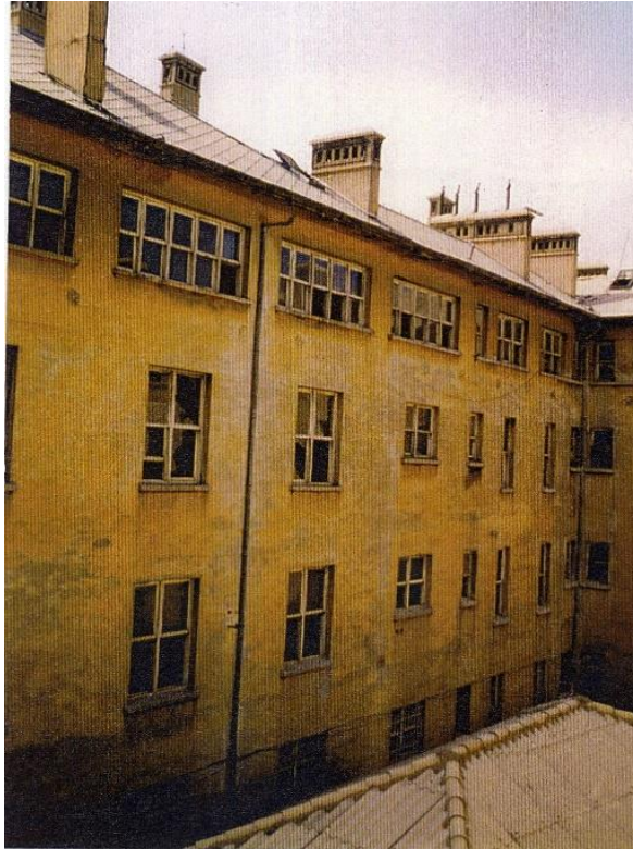
Şekil 5.84: İkinci Vakıf Apartmanı hava boşluğuna bakan pencereler (Ankara VGM Arşivi).
