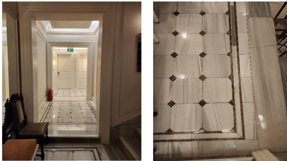
Şekil 5.24: Üçüncü Vakıf Han mermer kaplama döşemeler.
