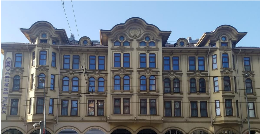
Şekil 5.44: Harikzedegan Apartmanları ön cephesi.
