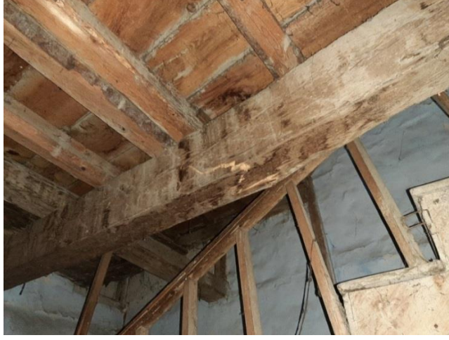
Şekil 4.81: B01 nolu odadaki kırılan kiriş, 2019.
