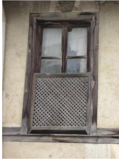
Şekil 4.53: Ahşap kafes, 2019.
