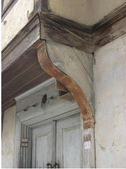
Şekil 4.52: Metal kaplı çıkma furuşu, 2019.
