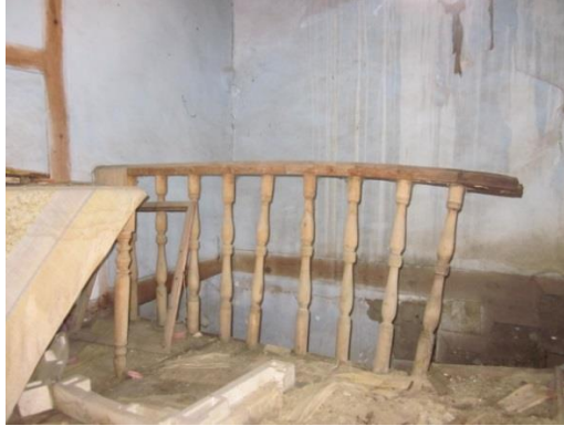
Şekil 4.29: 1. kat sofası merdiven parapeti, 2019.
