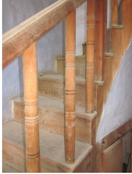
Şekil 4.69: 105 nolu oda dönel merdiven korkuluğu, 2019.
