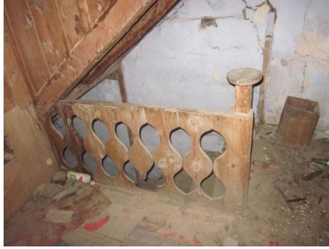
Şekil 4.4: Sofadaki merdiven parapeti, 2019.
