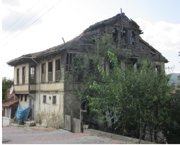
Şekil 4.57: Sokaktan yapıya bakış, 2018.
