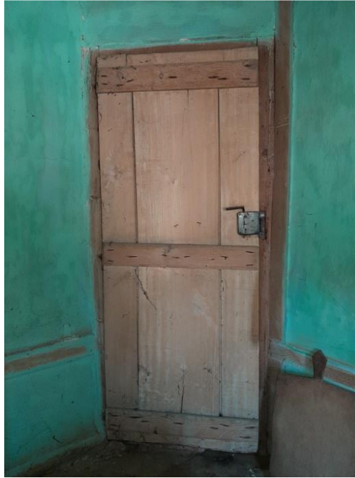
Şekil 4.72: Zemin kat kapı görünümü, 2019.
