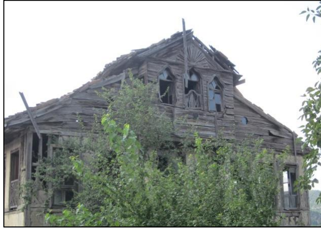
Şekil 4.55: Çatı katı görünümü, 2019.
