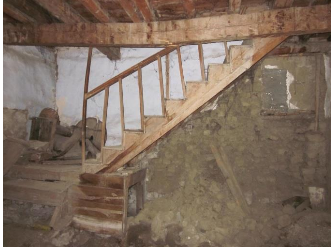
Şekil 4.20: Bodrum kat merdiveni, 2018.
