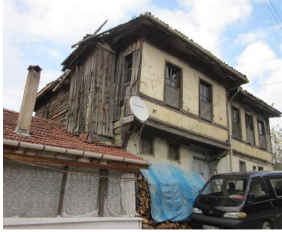
Şekil 4.62: Ocak kaldırılmadan önce, 2018.
