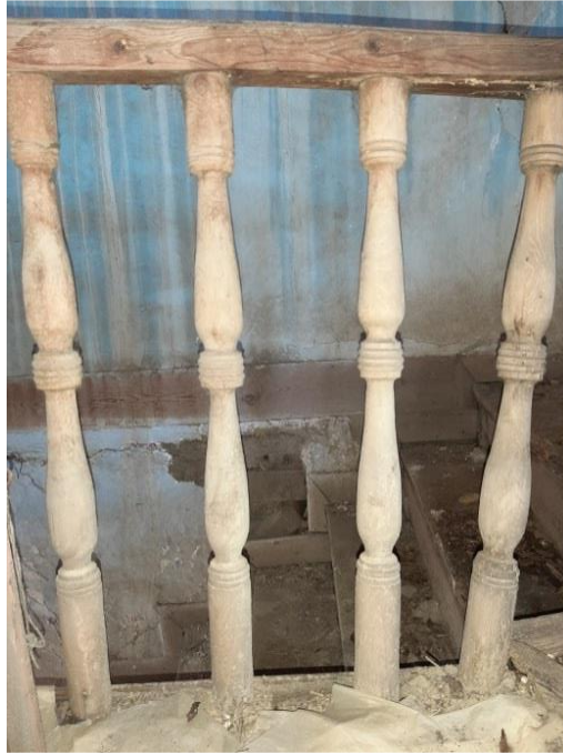
Şekil 4.68: 1. Kat sofada yer alan ahşap parapet, 2019.
