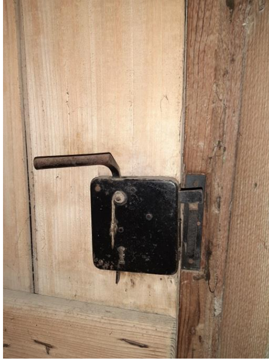
Şekil 4.73: Kapı kilit mekanizması, 2019.
