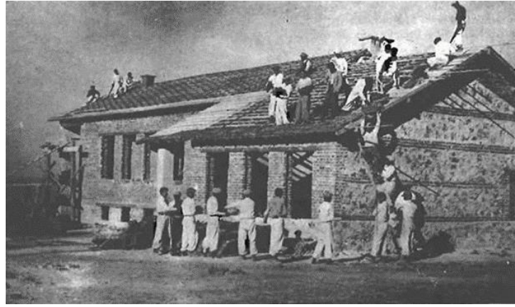
Şekil 2.24: Hasanoğlan Köy Enstitüsü'nde yığma taş ve tuğla sistem yapının öğrenciler tarafından inşası [Web 11, 2024].
