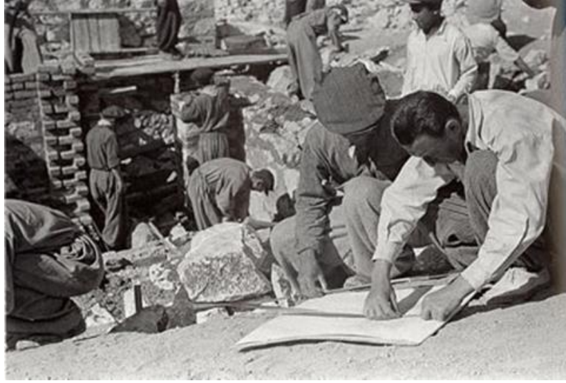
Şekil 2.28: Hasanoğlan Köy Enstitüsü şantiyesi [Web 11, 2022].
