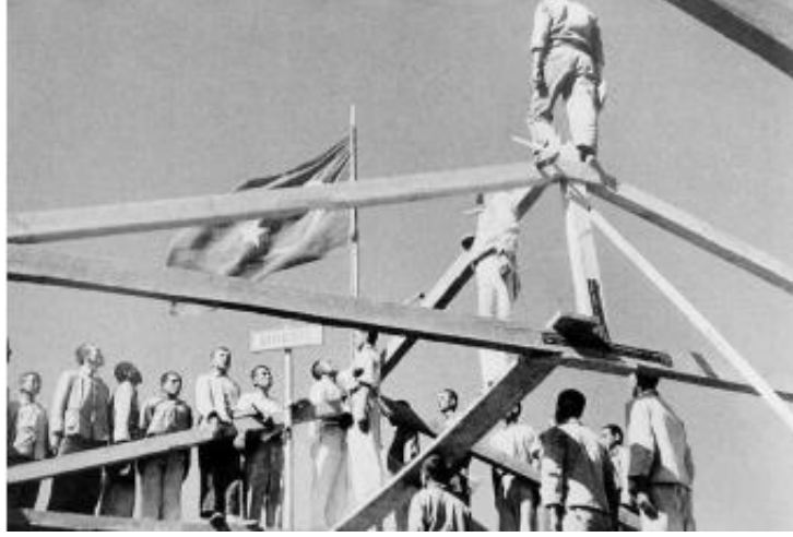
Şekil 2.30: Kepirtepeliler Hasanoğlu Köy Enstitüsü inşasında [Web 13, 2024]
