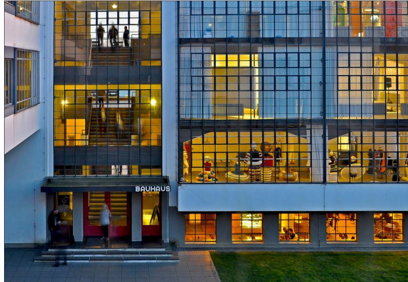
Şekil 2.15: Dessau yapısının cephesi [Lewandovski ve Merin, 2022].
