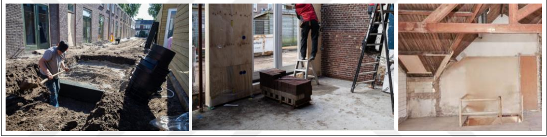
Şekil 3.30: Hafriyat ve iç mekân detayı.
