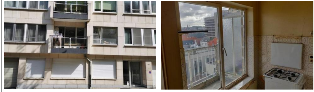
Şekil 3.24: Mevcut yapının uyarlama öncesi dış ve iç görünümü.
