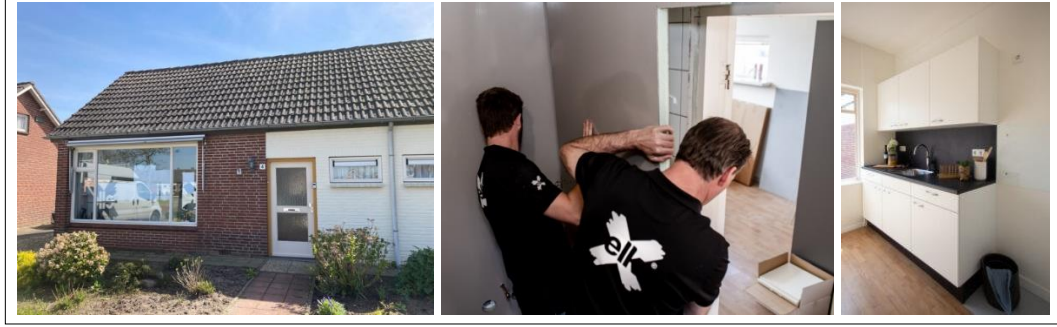
Şekil 3.26: Uyarlama sürecinde tek katlı konutların dıştan görünümü ve sökülebilir, geri kazanılmış elemanları.
