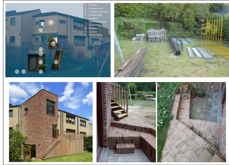
Şekil 3.7: Mevcut elemanların sökülmesi ve yapıda tekrar uygulanması.
