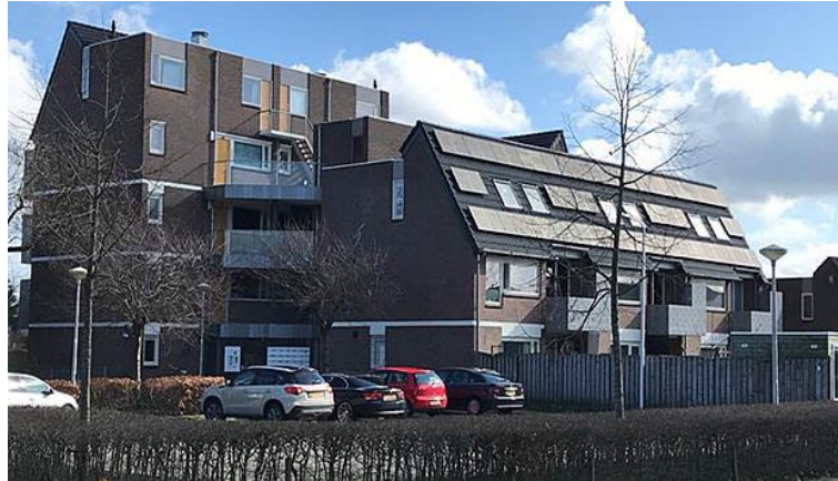
Şekil 3.10: Mevcut yapıların görünümü.
