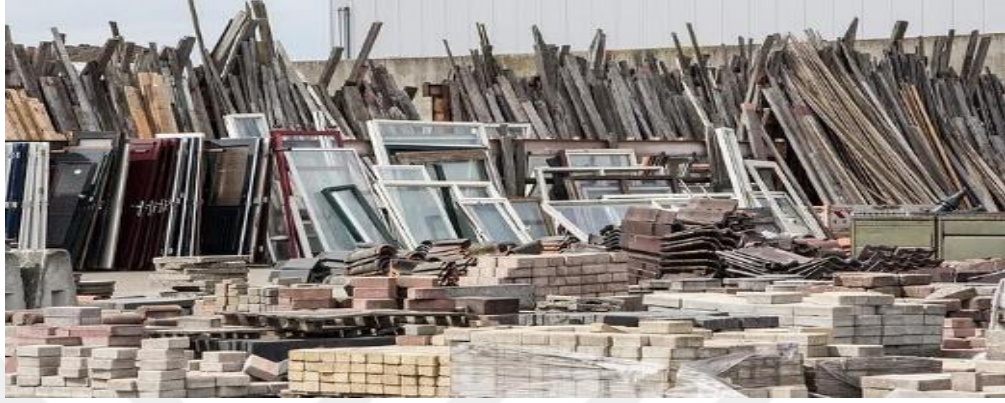
řekil 2.19: Geri kazanılmak zere skm iřlemi gerekleřtirilmiř yapı elemanları.
