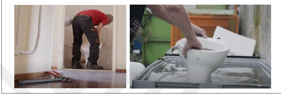
Şekil 3.33: Projede seramik yapı elemanlarının tekrar sırlanıp geri kazanılması.
