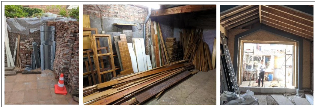
Şekil 3.23: Söküm işlemiyle mevcut yapıdan ayrıştırılan malzemeler ve uyarlama sürecinde sökülebilir bir şekilde yapıyla bütünleştirilmesi.
