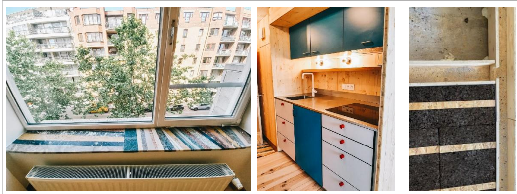
Şekil 3.25: Pencere ve mutfakta mermer ve çelik geri kazanılması ve zeminde biyolojik yalıtım malzemesi kullanımı.
