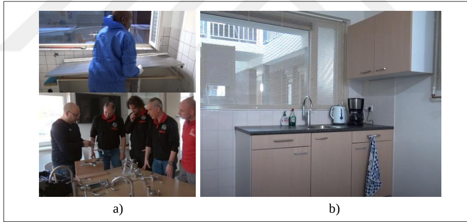
Şekil 3.12: a) Mutfak bölümünde malzemelerin geri kazandırılmak üzere sökülmesi, b) Mutfakın uyarlanmış son hali.
