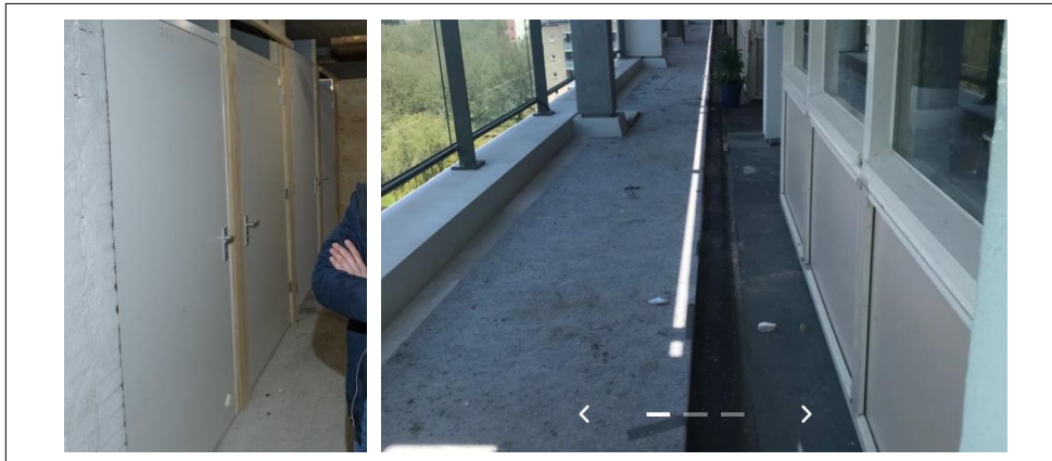
Şekil 3.21: Mevcut yapının zemin kat ve genişletilmiş balkonundan görünüm.
