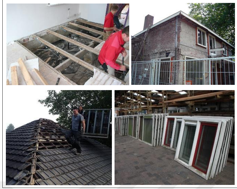
Şekil 3.9: Mevcut yapı elemanlarını söküm süreci.
