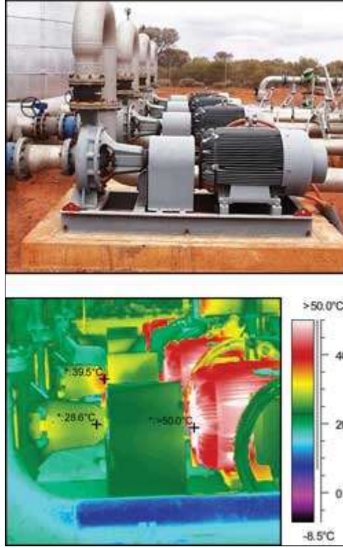
Şekil 2.11: Pompa sisteminde termal analiz
