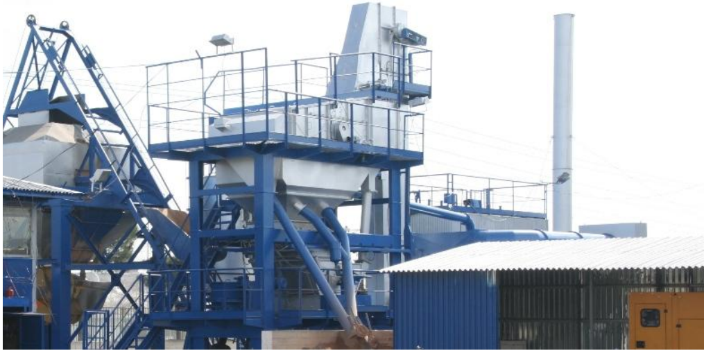
Şekil 4.2. Asfalt Tesisinin Genel Görünüm
