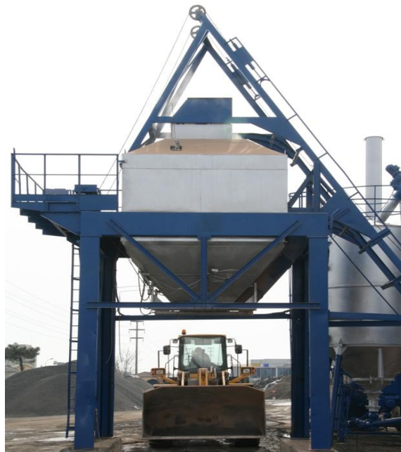
Şekil 4.3. Üretilen Asfaltın Depolandığı ve Kamyonlara Nakledildiği Silo
