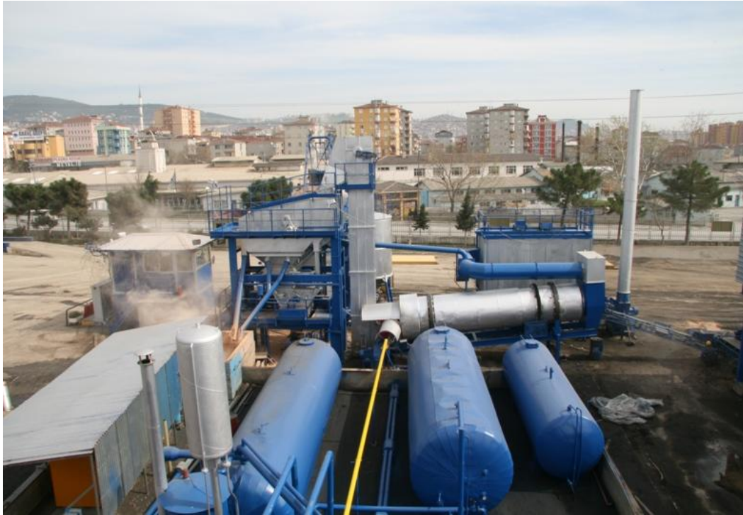
Şekil 4.1. Asfalt Tesisinin Genel Görünüm
