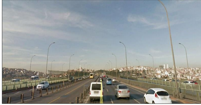
Şekil 9.23: D-100 Haliç köprüsü- Ayvansaray yönü görüntüsü.
