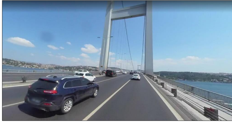
Şekil 9.19: 15 Temmuz şehitler köprüsü Avrupa yakası köprü girişi.
