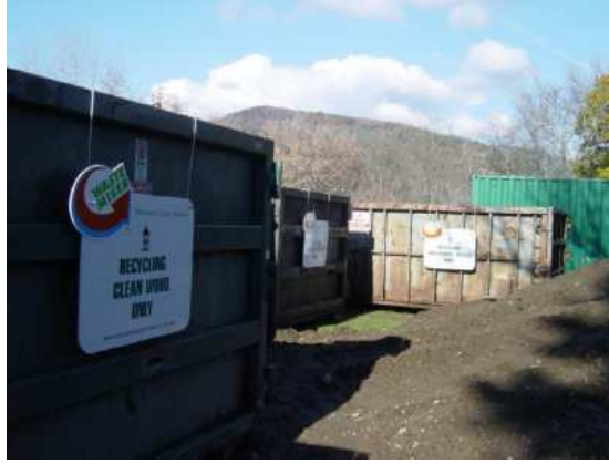
Şekil 3.3. Yapısal Atıkların Konteynırlarda sınıflandırılması
