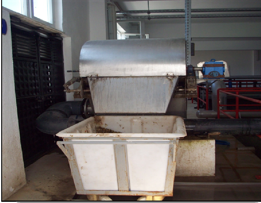
Şekil 3.9. Döner tambur eleğin yan kesitten görünüşü
