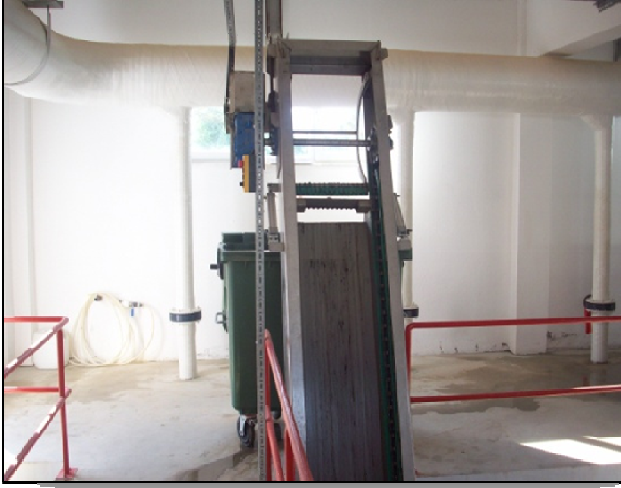
Şekil 3.2. Kaba ızgaranın önden görünüşü
