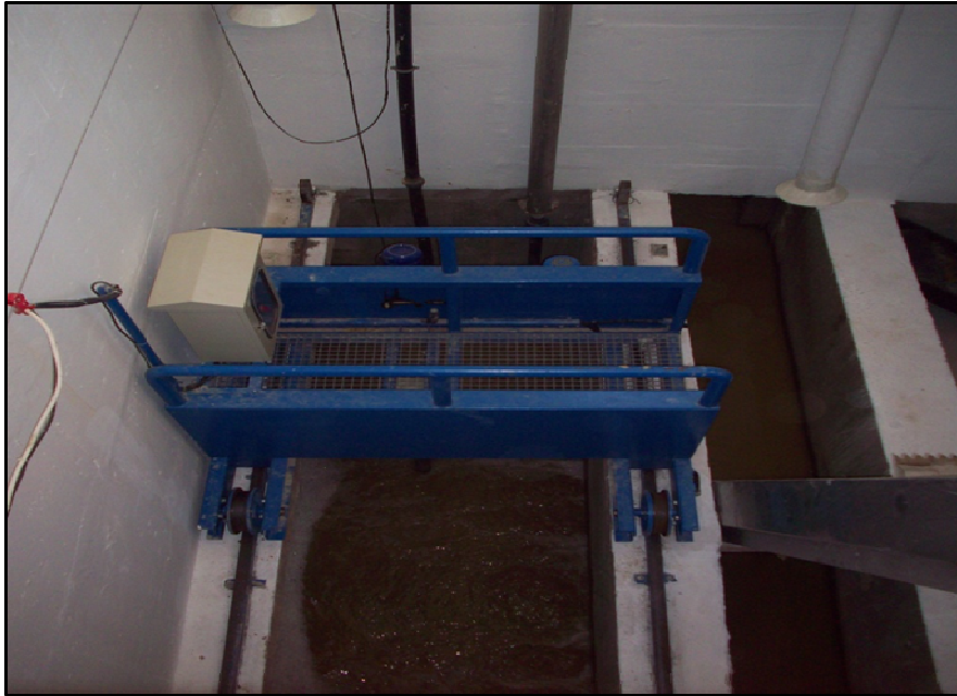
Şekil 3.4. Kum tutucu gezer köprüsü
