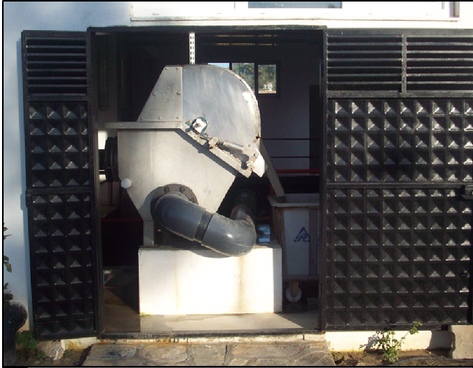
Şekil 3.8. Döner tambur eleğin ön kesitten görünüşü
