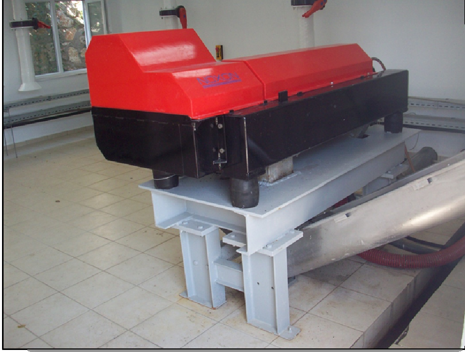
Şekil 3.20. Dekantör santrifüj sistemi
