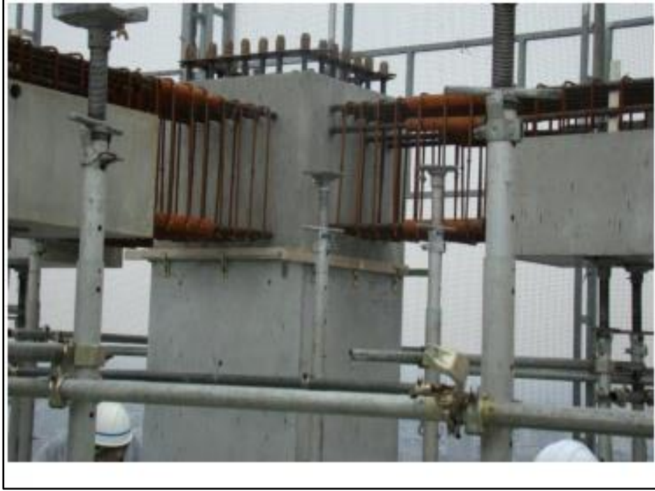
Şekil 3.10: Islak kolon kiriş bağlantısı uygulaması.
