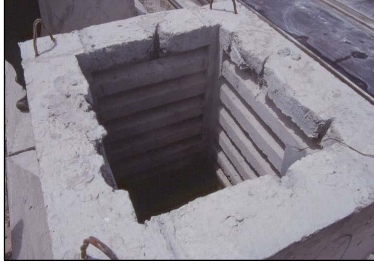
Şekil 3.16: Yuvalı temel detayı.
