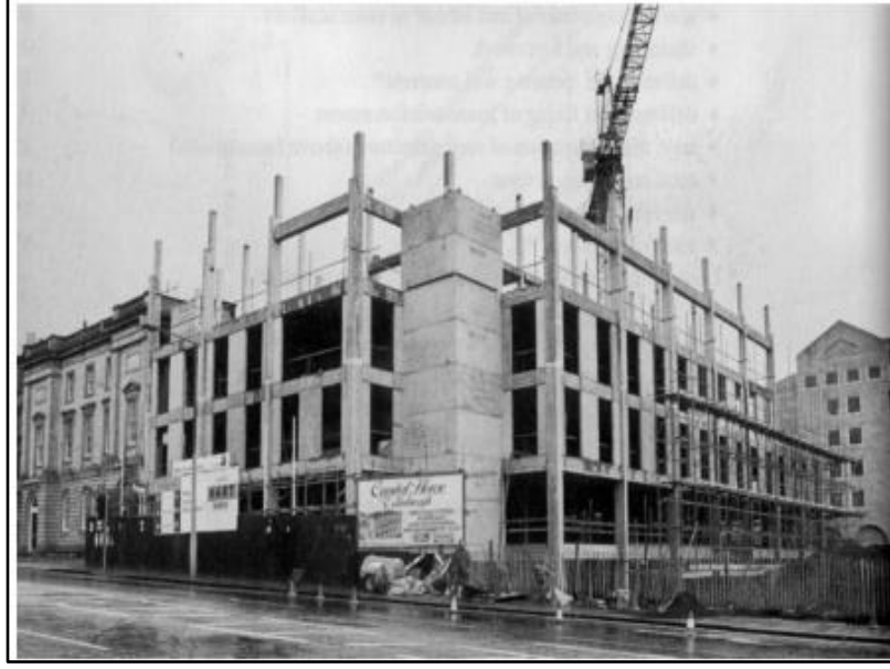
Şekil 2.1: Çok katlı perdeli kolon kiriş sistem.
