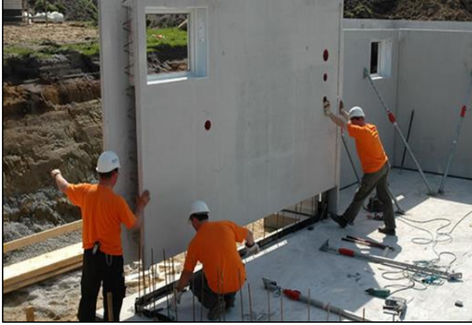
Şekil 2.13: Prefabrik çift cidarlı panel.
