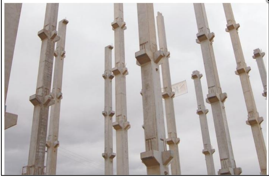
Şekil 2.8: Prefabrik betonarme kolon.
