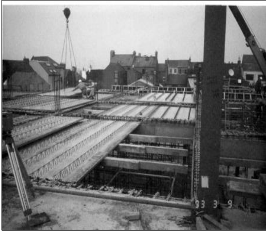
Şekil 2.11: Prefabrik filigran döşeme montajı.
