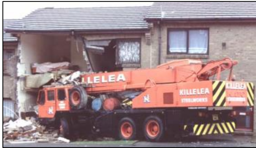
řekil 4.20: arpma ykne maruz kalmıř yapı rneėi.
