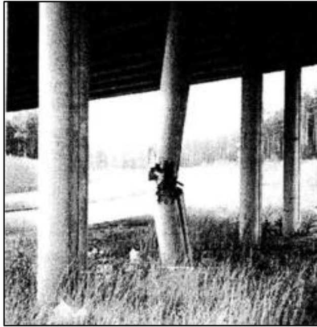
řekil 4.19: arpma ykne maruz kpr ayaėı.
