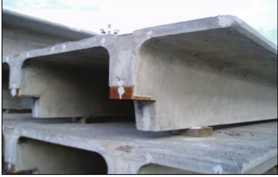
Şekil 2.12: Prefabrik T plak döşeme.
