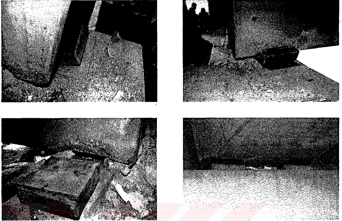
Şekil 4.3. Elastomerlerde Meydana Gelen Hasar Örnekleri
